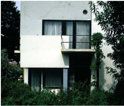
الشكل(15:3): الواجهة الأمامية للمسكن. (المصدر: www.greatbuildings.com ).
